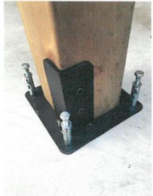
Mit Sockel: Ein Grabgraben mit den richtigen Abmessungen für die Hauptpfähle ist erforderlich. Machen Sie ein Rinnsal Beton im Graben, bevor Sie die Platten mit Dübeln befestigen.
