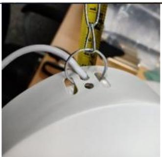
7. Sobald die 4 hängenden Ketten fest an der Rundlampe verschraubt sind, überprüfen Sie, ob das andere Ende der Ketten sicher am Metallhalter der Decke befestigt ist. Die Metallketten sind miteinander verbunden, sodass die Länge/Höhe der hängenden Lampe nach Ihren Wünschen angepasst werden kann. Tun Sie dies, bevor Sie den Metallhalter der Decke am Halter befestigen.
