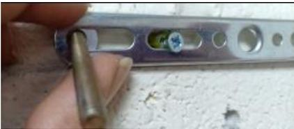
5. Befestigen Sie den Metallhalter an der Wand/Decke.
