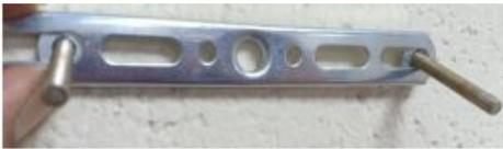
2. Verwenden Sie die Befestigungsstütze als Schablone, um die Bohrlöcher an der Decke zu markieren.
